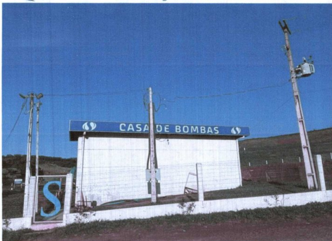
Casa de Bombas
